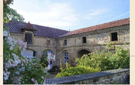
LES COMMUNS DU CHÂTEAU DE L'ARTHAUDIÈRE
