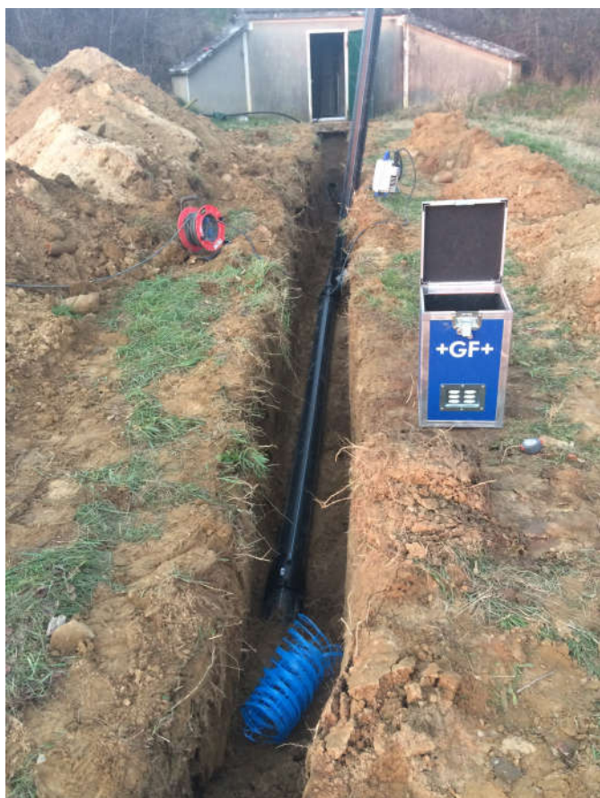
Nouvelle conduite de Bel Air
