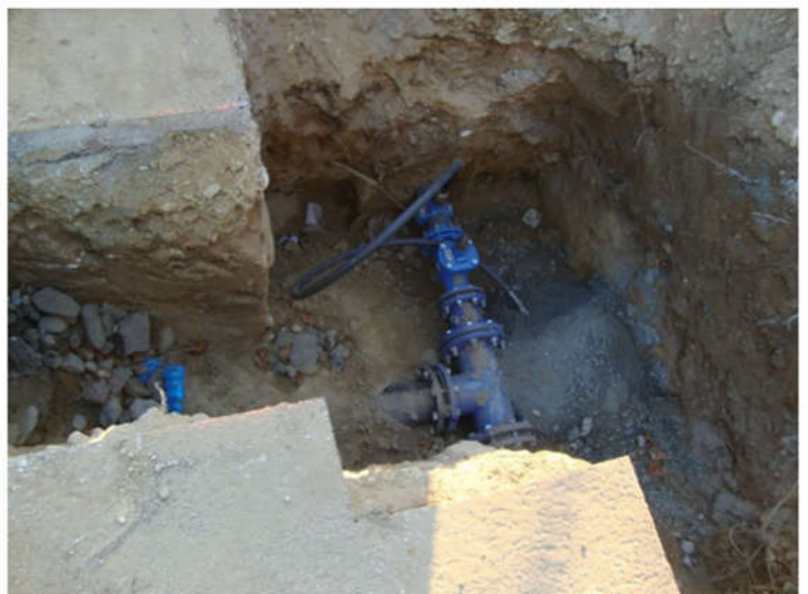
Travaux de Bel Air
